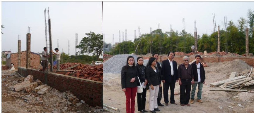
Site du chantier du centre d'éducation et d'apprentissage de Nam Dinh
